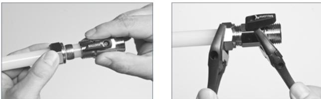
3. Montieren Sie Überwurfmutter, Schneidring und Kugelhahn.
