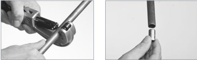
1. Das Rohr wird mit einem Rohrschneider oder einer Handsäge auf die korrekte Länge gekürzt. Entfernen Sie eventuelle Grate mit geeignetem Werkzeug.
