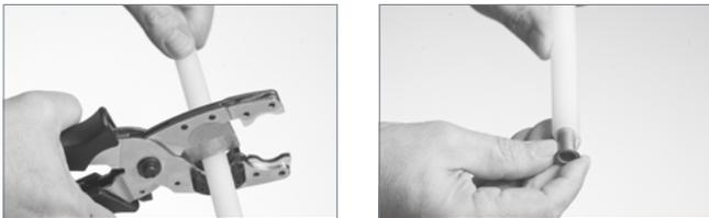
1. Das Rohr wird auf die korrekte Länge gekürzt.
